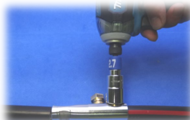
せん断ボルトを締め付け
